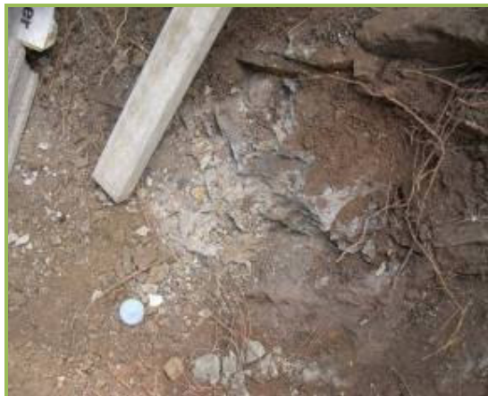
Imagen 3: Detalle de zona picada para ajustar el espacio existente a las medidas requeridas.
