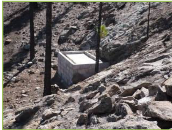
Imagen 36: Detalles del proceso de construcción: Depósito de Alsándara.
