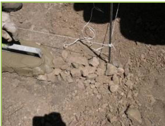
Imágenes 6 y 7: Detalle del proceso de construcción de la base de los bloques.
