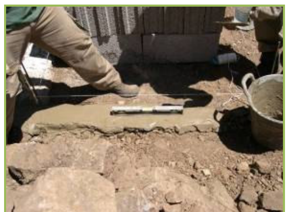
Imágenes 6 y 7: Detalle del proceso de construcción de la base de los bloques.
