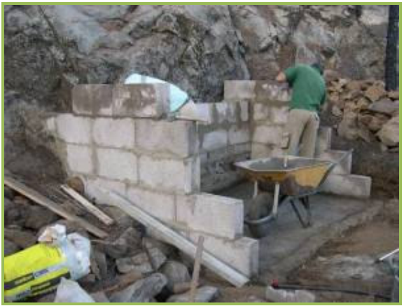
Imágenes 32-35: Detalles del proceso de construcción: Depósito de Alsándara.
