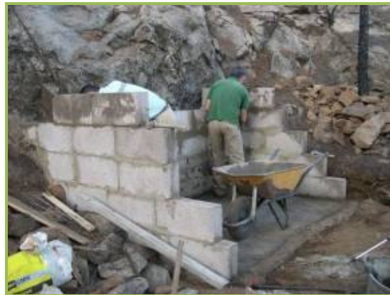
Imagen 12: Detalle de construcción de la estructura.
