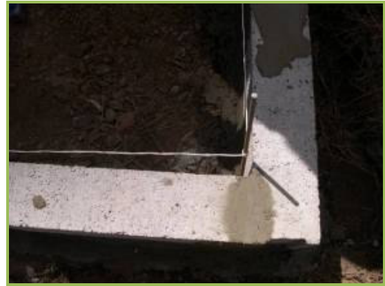
Imágenes 4 y 5: Detalle del trazado con hilos para levantar los muros de bloque
