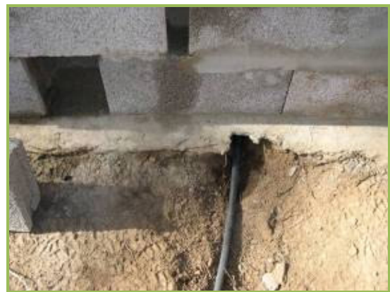
Imagen 8: Detalle de la construcción del suelo Y Imagen 9: Detalle de los agujeros para la salida de la manguera y para la manipulación de la llave de paso.
