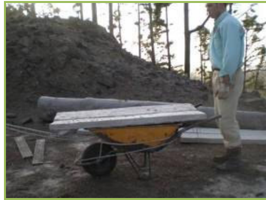
Imágenes de las viguetas y su transporte a los depósitos.
